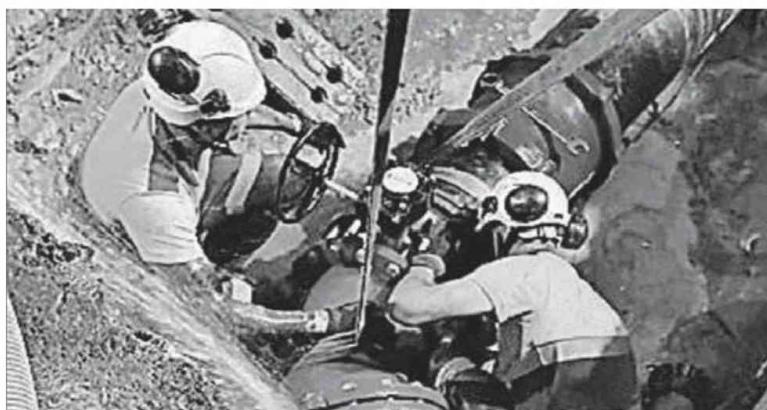
Foto de archivo de trabajos en una tubería. LA VOZ
