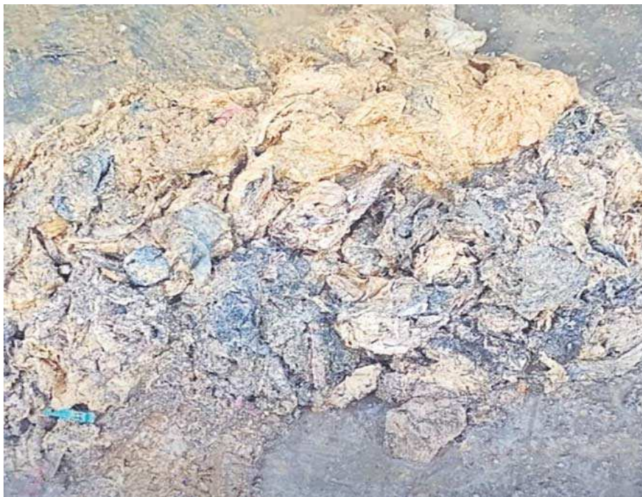
Toallitas acumuladas en la red de saneamiento.
